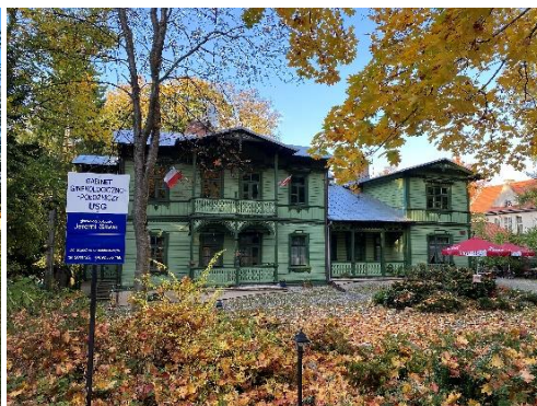
Fig. 15. Willa Nagórze, 27 Lipowa Street in Nałęczów, 2021, source : own study
