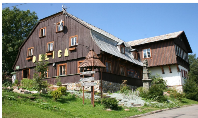
Rys. 4. Schronisko Orlica w Zieleńcu wzniesione w 1878 roku. Budynek o konstrukcji wieńcowej ścian, krytych z zewnątrz pionowo ułożonymi deskami oraz z mansardowym dachem z lukarnami, posiada również wyżkę w formie dobudówki, opartej na murowanych ścianach parteru. W pobliżu Orlicy istniał drugi gościniec ( Gasthaus zur Mense ), o podobnej formie i konstrukcji, lecz został rozebrany w latach 60. XX wieku. Fot. Jacek Suchodolski 2009
