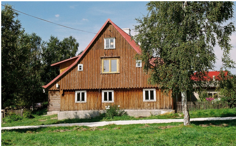
Rys. 13. Lasówka (Kaiserswalde). Dawne schronisko Erlitztalbaude, obecnie budynek mieszkalny. Blacha na dachu została przybita poprzez łąty do pierwotnego pokrycia gontowego. Fot. Jacek Suchodolski 2005
