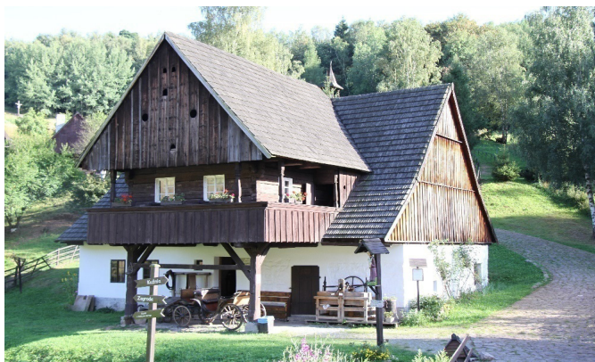
Rys. 3. Pstrążna – skansen budownictwa drewnianego. Przeniesiony z Szalejowa Dolnego budynek tzw. Zajazdu ( powstały prawdopodobnie w 1 poł. XIX wieku). Skromną formę parterowego domu o konstrukcji wieńcowej ścian urozmaica wyżka, czyli dobudówka wysunięta poza krawędź okapu dachu, oparta na słupach, w której znajdowały się pomieszczenia dla turystów. Fot. Jacek Sucho-dolski 2015
