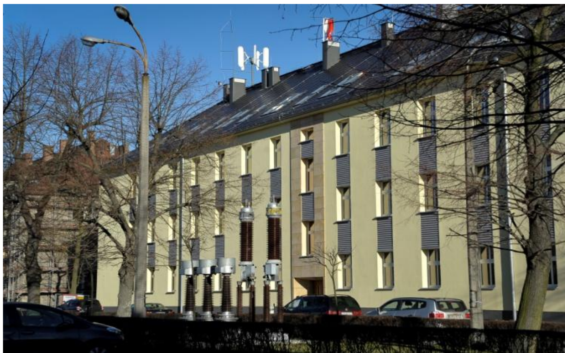
Rys. 4. II Kampus Politechniki Opolskiej na ul. Prószkowskiej (budynek Instytutu Elektroenergetyki i Energii Odnawialnej Wydziału Elektrotechniki, Automatyki i Informatyki – po remoncie)
