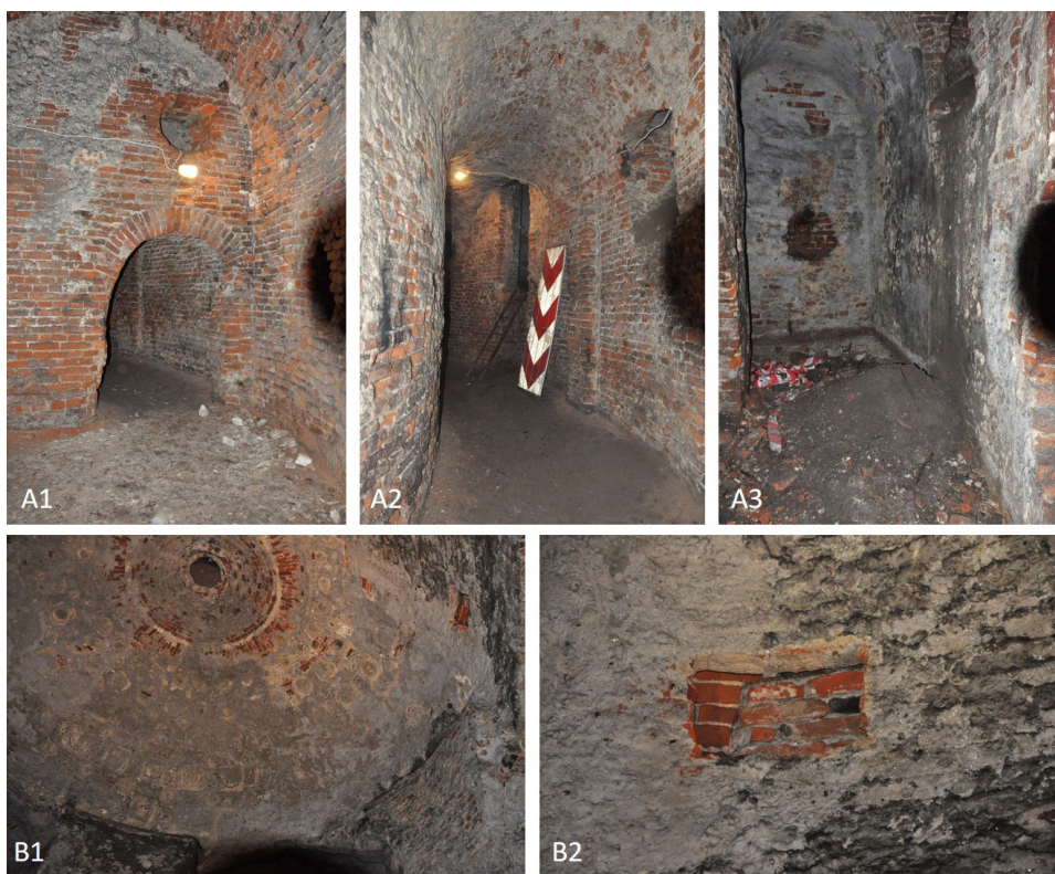
Ryc. 7 Elizeum, A – korytarz obwodowy: dolny, na prawo od współczesnego wejścia (A1), dolny, odcinek zachodni, widoczny wlot komina wentylacyjnego i wejście na górną kondygnację (A2), górny, widok na lewą ścianę zamykającą korytarz (A3); B – kopuła: widok ogólny, widoczne ślady pierwotnego wystroju i zarys pierwotnego oculusa (B1), odkrywka w wewnętrznym płaszczu kopuły (B2). Fot. L. Narębski, 2017
