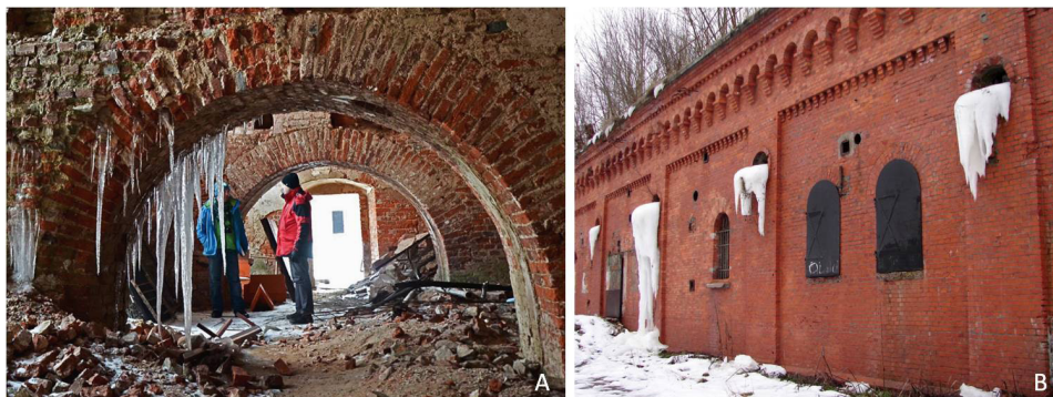
Ryc. 9 Obiekty forteczne zimą. „Utrwalone” wycieki wody: A – z przykrytych ziemią sklepień Bastei Dolnej Donżonu Twierdzy Srebrna Góra (fot. G. Basiński); B – z rzygaczy na elewacji koszar sztyjowych Fortu I Twierdzy Toruń (fot. L. Narębski)
