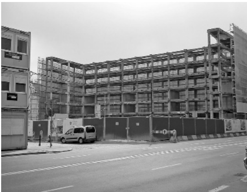
Fot. 2. CDT „Smyk” w trakcie „przebudowy”, widok od ul. Kruczej (fot. J. Dąbrowski)
