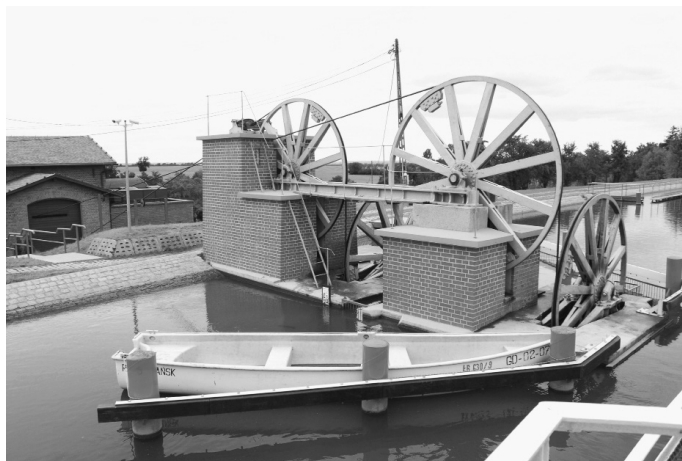
Fot. 3. Kanał Elbląski, zabudowa pochylni Oleśnica, 1860. Zespół zabytków techniki o wartości europejskiej (ponadkrajowej) wpisany do rejestru zabytków i uznany za Pomnik Historii. Fot. J. Lewicki 2016.
