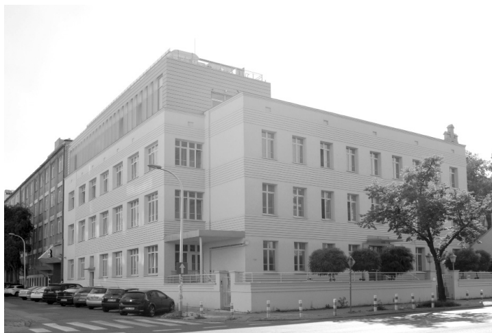
Fot. 7. Warszawa, modernistyczny budynek na ul. Rakowieckiej 19, 1927, jeden z pierwszych obiektów funkcjonalizmu w Polsce. Budynek o wartości ponadregionalnej nie wpisany do rejestru zabytków, przebudowany i nadbudowany. Fot. J. Lewicki 2016.
