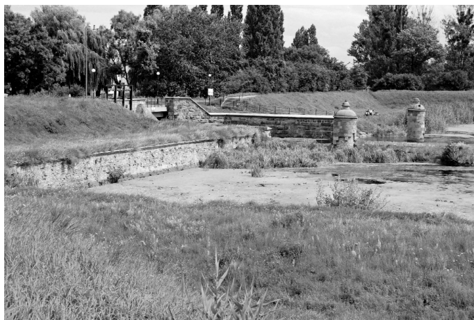
Fot. 2. Gdańsk, fortyfikacje miasta, kamienna śluza, XVII w. Zabytek techniki o wartości europejskiej (ponadkrajowej) wpisany do rejestru zabytków. Fot. J. Lewicki 2016.
