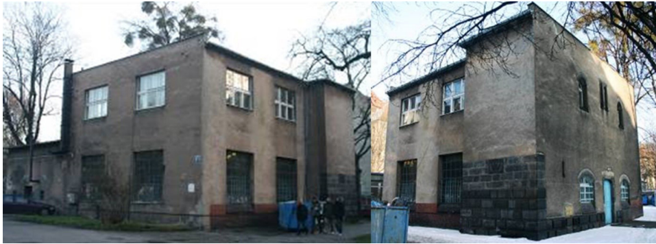
Ryc. 4 Budynek dawnego laboratorium maszynowego, stan przed przystąpieniem do prac w 2009r., fot. A. Grylewska, źródło: Grylewska A., Brzezowski W., Studium historyczne z wnioskami konserwatorskimi kompleksu dawnej Baugewerk und Maschinenbauschule, obecnie budynków Politechniki Wrocławskiej przy ul. B. Prusa 53/55 we Wrocławiu , Sprawozdanie z serii nr 029/09, rękopis, Wrocław 2009
