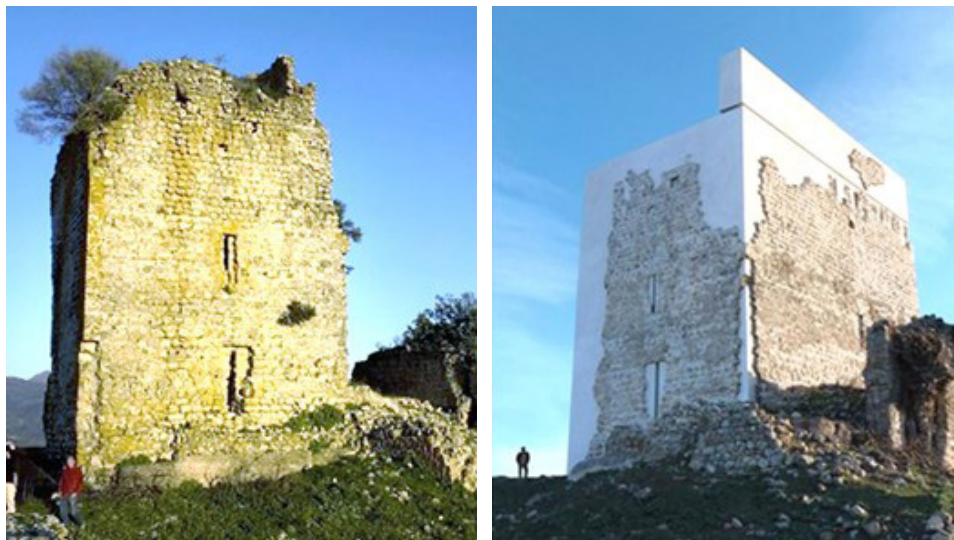
Ryc.1 Castillo Matrera, ruiny wieży przed i po przekształceniu; źródło: https://www.medieval.eu/matrera-castle-vilharigues-tower/ - dostęp 20.10.2020
