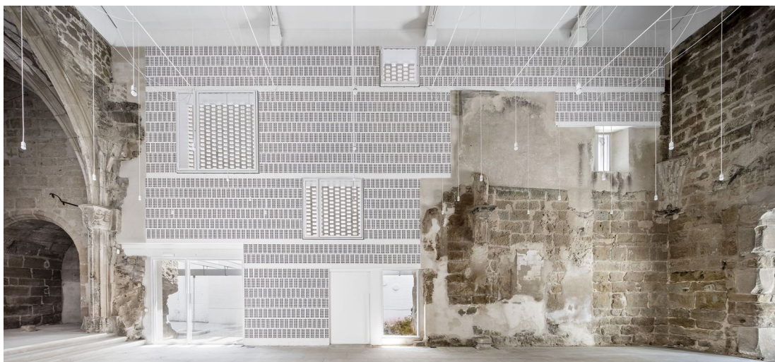
Il. 5. Santa Maria de Vilanova de la Barca, Hiszpania (2016) – widok na wnętrze zadaszonych ruin, źródło: https://www.archdaily.com/803620/santa-maria-de-vilanova-de-la-barca-aleaolea-architecture-and-landscape (dostęp: 20.09.2021).
