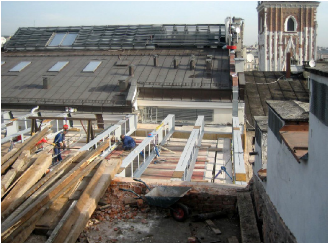
Il. 16 Budowa zadaszania patio i Sali Panoramicznej na oficynie proj. Atelier Loegler i Włodarczyk+Włodarczyk Architekci, fot. M. Włodarczyk.
