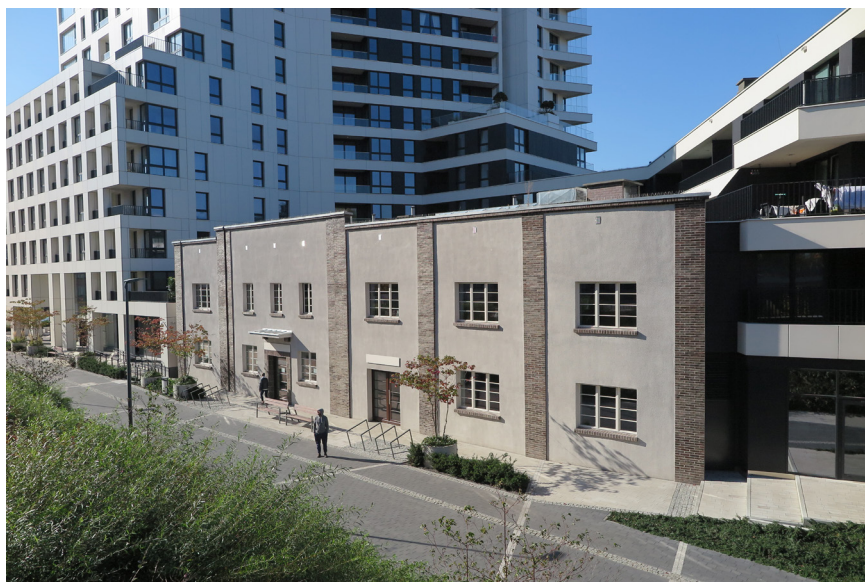
Fot. 7. Elewacje budynku firmy Hartwig przy ul. Węglowej 22 (niska część z pionowymi pasmami), pozostawione w strukturze nowej zabudowy mieszkaniowej przy ul. Węglowej, 2021 r., fot. K. Gieldon
