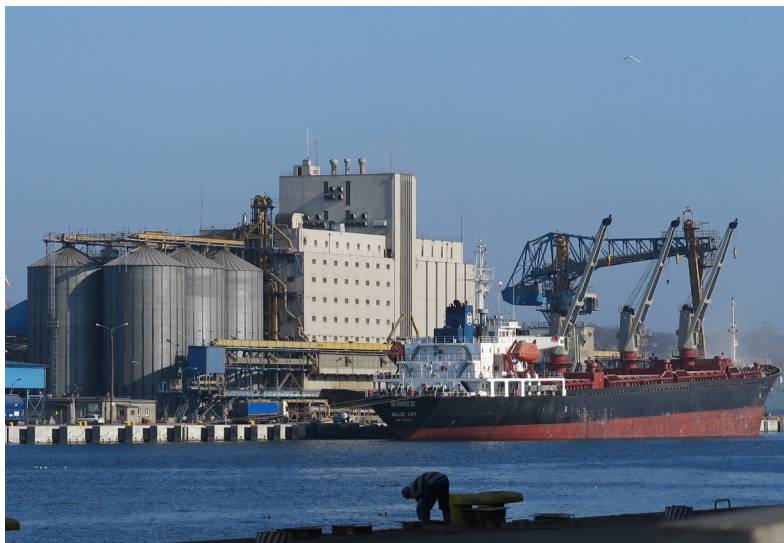
Fot. 1. Elewator Zbożowy z dobudowanymi silosami (z lewej strony), 2016 r., fot. R. Hirsch
