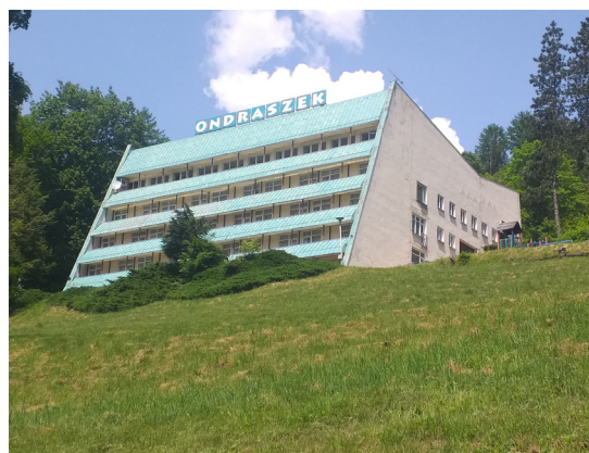
Ryc.2. Arch. arch. J. Winnicki, Cz. Kotela, I. Kotela, Z. Winnicki – dom wczasowy typu „punktowiec” w Ustroniu-Jaszowcu o zachowanej oryginalnej formie (fot. B. Ciarkowski)
