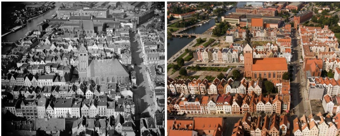
Ryc. 24 Stare Miasto w Elblągu rok 1922 i 2020. Źródło: Registratura Departamentu Urbanistyki i Architektury UM w Elblągu
