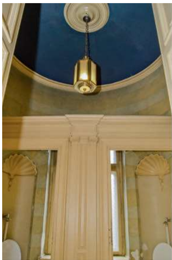
Il. 3. Przestrzeń pierwszego piętra Pałacu rodziny Poznańskich przed remontem, fot. Bożena Szafrąńska, materiały MMŁ
