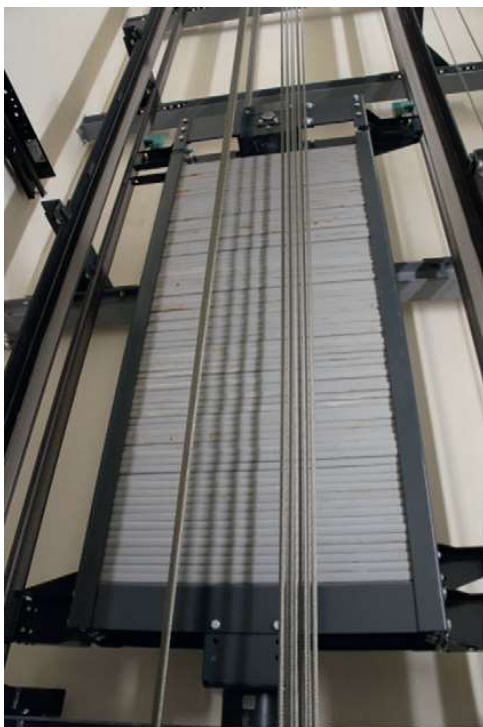
Fot. 19. Przeciwwaga dźwigu, przed nią widoczne prowadnice kabinowe T 127 x 89 x 16, za nimi prowadnice przeciwwagi T 50 x 50 x 9, rok 2020; fot. R. Jeżowski
