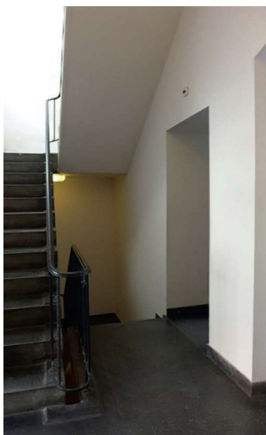
Fot. 6. Klatka schodowa przed rozbiórką, rok 2015; fot. S. Pankiewicz
