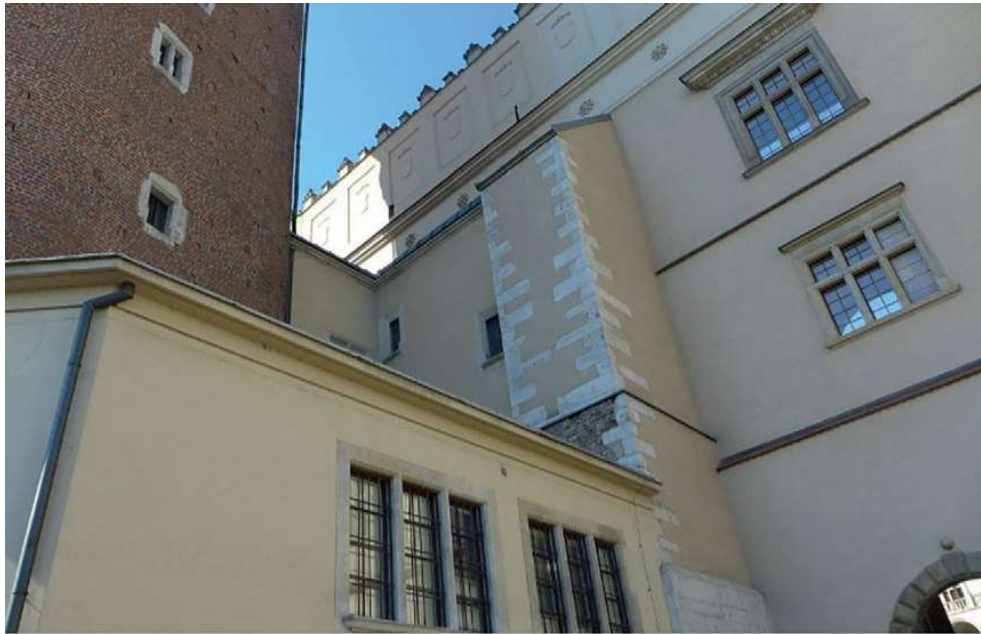
Fot. 2. Południowe skrzydło Dziedzińca Arkadowego od zewnątrz; za przyporą widoczna klatka schodowa z dwoma okienkami przeznaczonymi do zamurowania, rok 2015; fot. S. Pankiewicz
