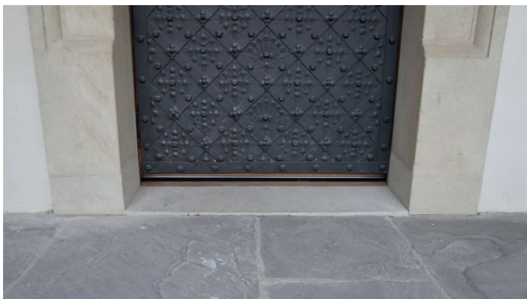
Fot. 11. Wejście na parterze krużganków po przebudowie – bez stopnia, rok 2020; fot. R. Jeżowski
