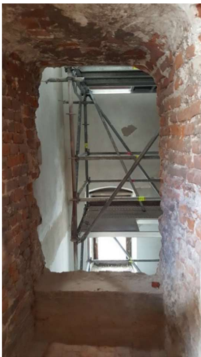
8. Przebicie z krużganków do szybu dźwigowego, rok 2018; fot. S. Pankiewicz
