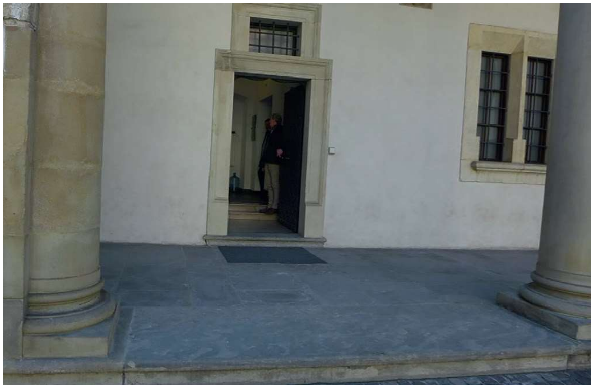
Fot. 4. Bariery dostępu dla osób z niepełnosprawnością z dziedzińca: jeden stopień na całej długości krużganków, jeden stopień w portalu, dwa stopnie we wnętrzu na parterze, rok 2015; fot. S. Pankiewicz
