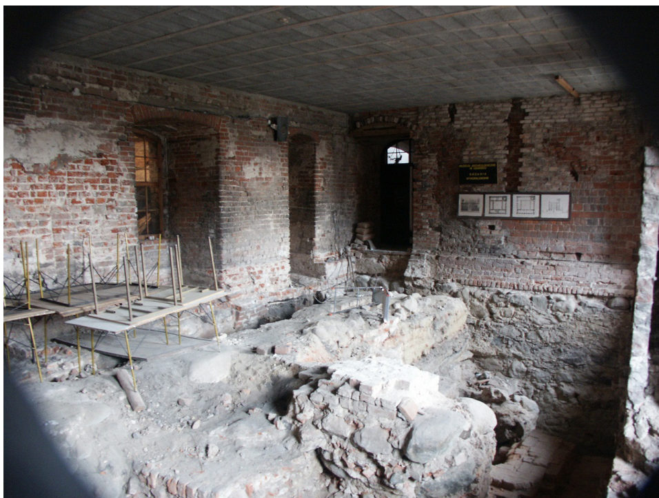
Ryc. 13 Przyziemie skrzydła zachodniego po odgruzowaniu i budowie stropu w 2003 roku, Fot. Marcin Gawlicki
