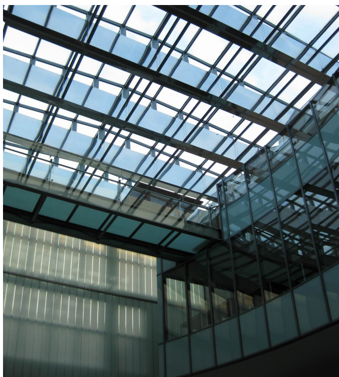
Ryc. 8. Międzynarodowe Centrum Kultury, Rynek Główny 25 Kraków, współczesna adaptacja historycznej kamienicy do nowej funkcji, Fot. M. Włodarczyk 2017
