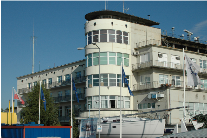
Fot. 2 Dawny Dom Żeglarza Polskiego, obecnie Wydział Nawigacyjny Akademii Morskiej w Gdyni, zbudowany według projektu Bohdana Damińskiego i Tadeusza Sieczkowskiego z 1937 r., rozpoczęty w latach 1938-1939 i ukończony po 1945 roku (fot. M. J. Sołtysik)
