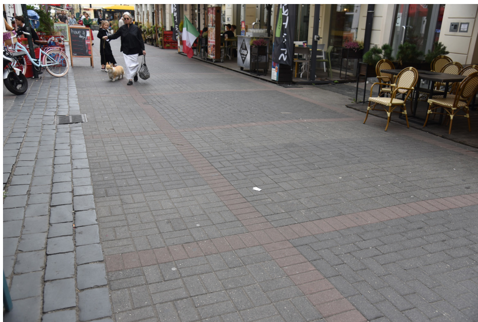
Ryc. 1b Warszawa – ulica Chmielna, stan w 2022 roku. Fragment nawierzchni. Fot. J. Lewicki
