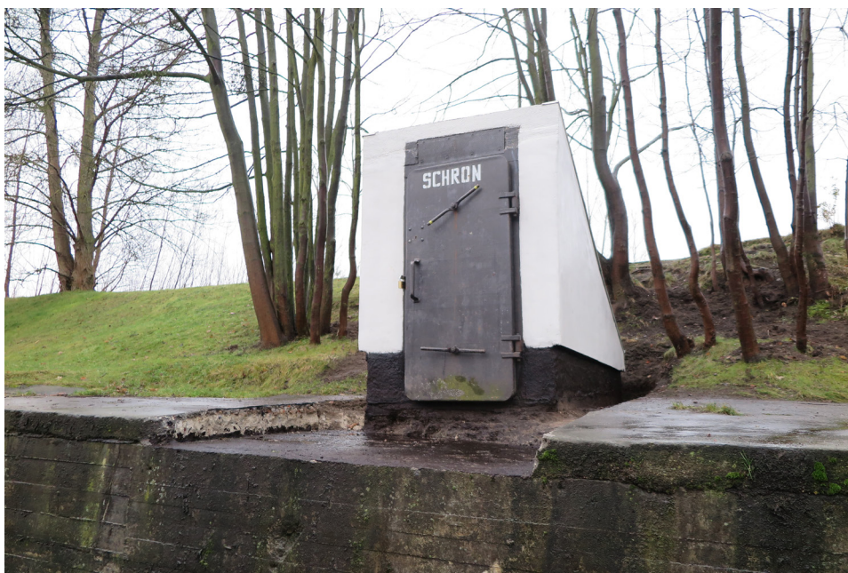
Ryc. 3 Schron przy ul. Morskiej w Gdyni Leszczynkach, po rewaloryzacji przez Gdyński Klub Eksploracji Podziemnej (fot. Biuro MKZ w Gdyni)
