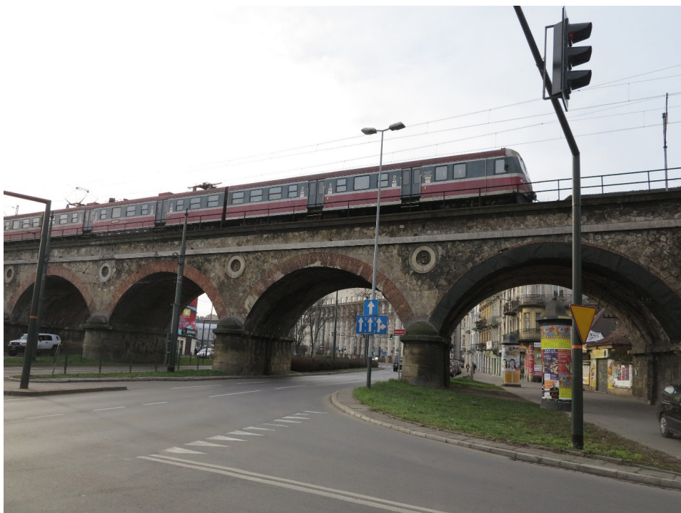
Ryc. 3 Kraków, wiadukt kolejowy z 1863 r. przed rozbiórką i odtworzeniem w nowej technologii. Przykład relatywizacji stosunku do zabytku. (fot. A. Siwek)
