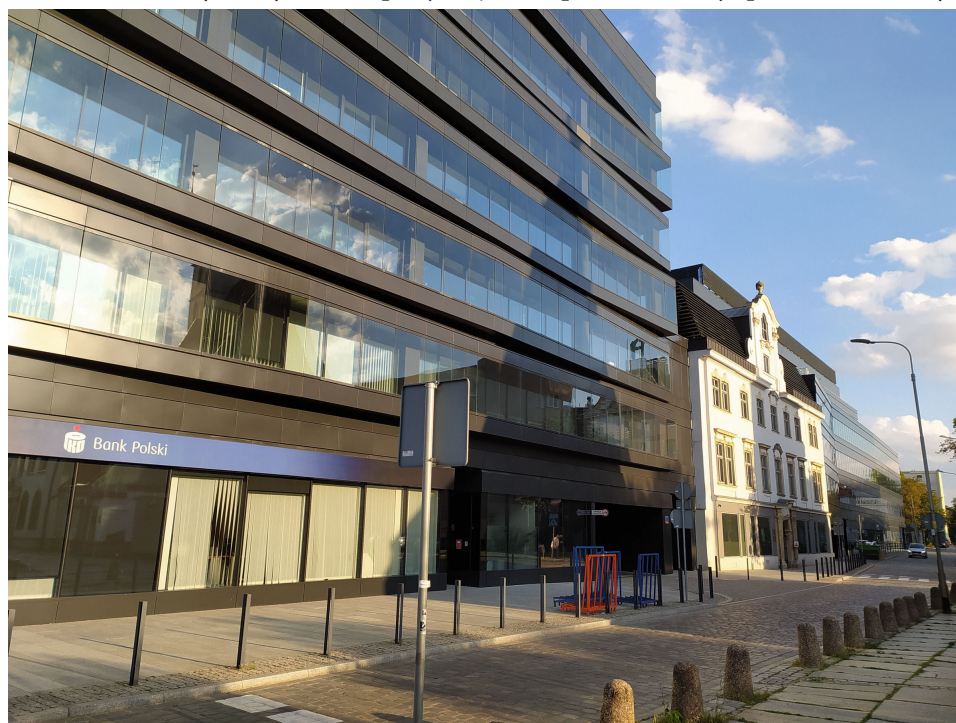
Ryc. 1 Odrestaurowany pałac Oppersdorfów we Wrocławiu przytłoczony kompleksem biurowym, fot. I. Niedźwiecka-Filipiak, 2024
