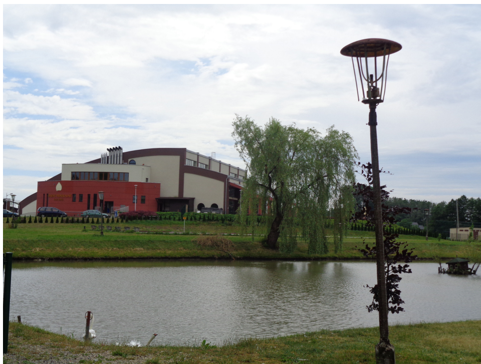
Ryc. 8 Dominująca, agresywna w formie zabudowa w bezpośrednim sąsiedztwie historycznej części uzdrowiska Solec - Zdrój, fot. D. Sikora, 2018
