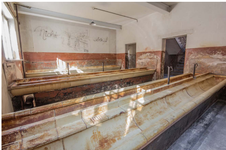
Fot. 2. Sanitariaty w bloku nr 2 dawnego KL Auschwitz I – widoczne odsłonięte podczas prac konserwatorskich dekoracje ścian pochodzące z okresu funkcjonowania obozu oraz elementy nowych instalacji, wprowadzone z wykorzystaniem istniejącej infrastruktury budynku (fot. A. Śmiałek)
