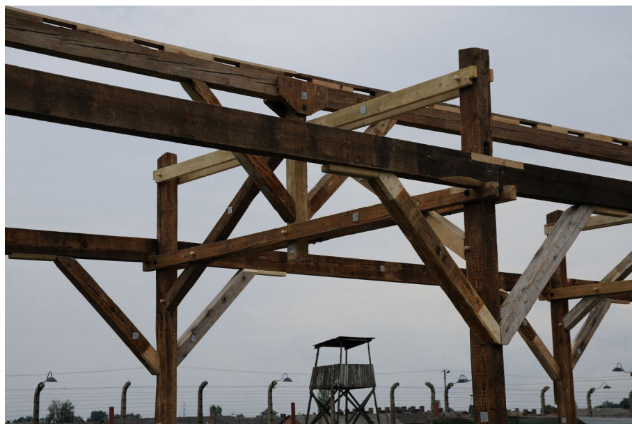
Fot. 4. Elementy drewnianej konstrukcji baraku wzmocnione zgodnie z zasadą minimalnej ingerencji (Fot. Z. Drabczyk)
