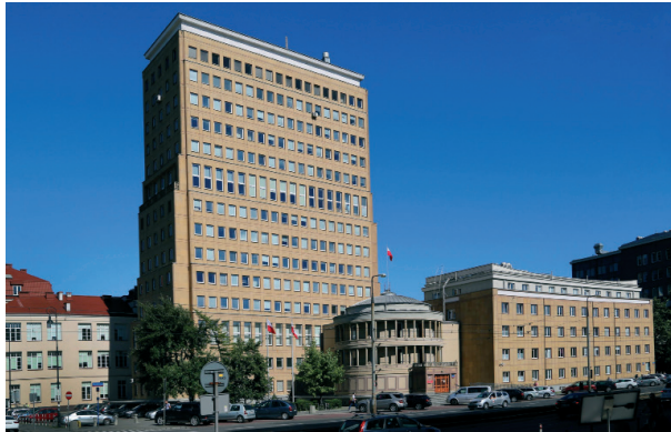
Il. 1. Warszawa. Biurowiec Ministerstwa Komunikacji. Proj. Bohdan Pniewski (1948–1950). Fot. P. Kobek (2016), Zb. NID.
