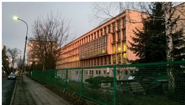
Ryc. 3. Budynek biurowy d. drukarni im. Rewolucji Październikowej, Warszawa ul. Mińska 65 (fot. J. Dąbrowski, 2017)
