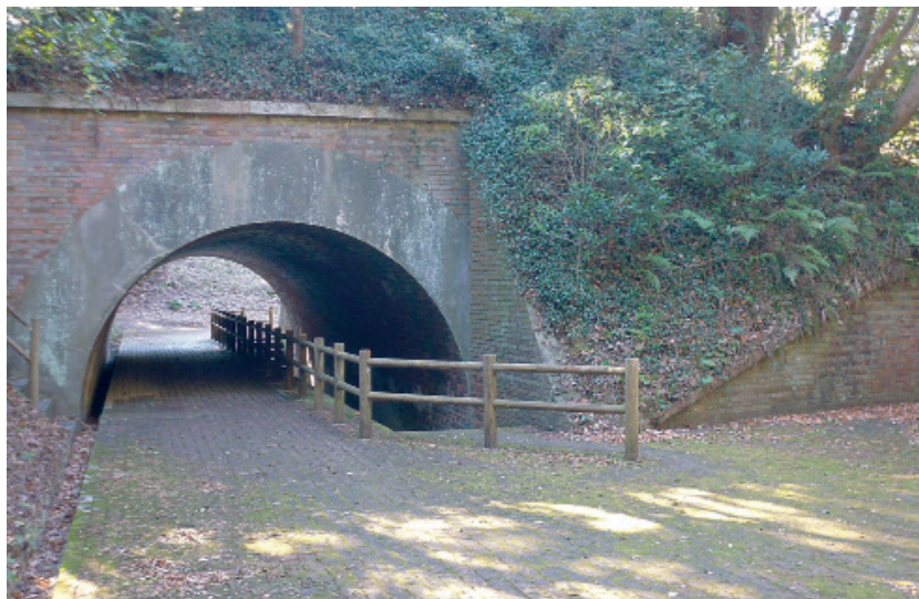
Il.13. Park narodowy Kada Setonaikai, trwała ruina zaporowego fortu artyleryjskiego Miyama forticy Yura strzegącej przesmyku morskiego Kishi do Zatoki Osaka; zbudowany z importowanych cegieł ceramicznych w 1889, został wyposażony w 1892 w sześć haubic 28 cm o zasięgu 7800 m, częściowo produkcji japońskiej według projektu niemieckich zakładów Kruppa. Fot. W. Affelt 2016
