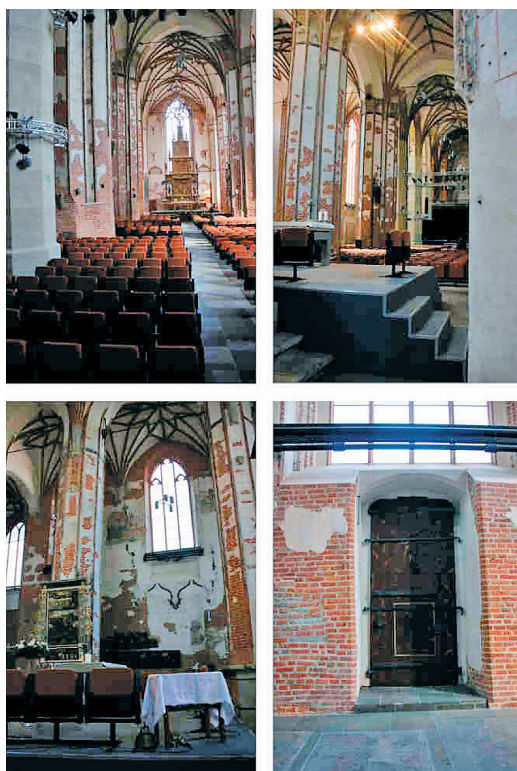
Ryc. 5. Gdańsk, kościół św. Jana. Wybrane fragmenty wnętrza. Stan po pracach konserwatorskich. Fot. K. Szczepanowska.
