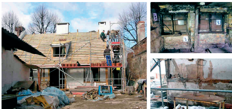
Ryc. 2. Gdańsk Gościnną 10. Dom podmiejski z kuźnią w trakcie prac konserwatorsko-restauratorskich. Fot. K. Szczepanowska.
