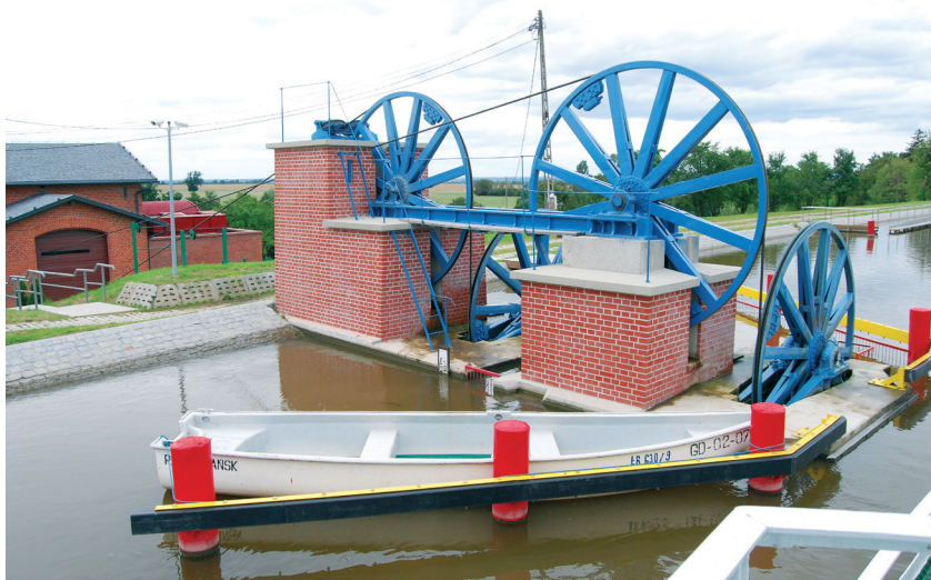
5. The Elbląg Canal, ramp. Photo: J. Lewicki, 2016.
