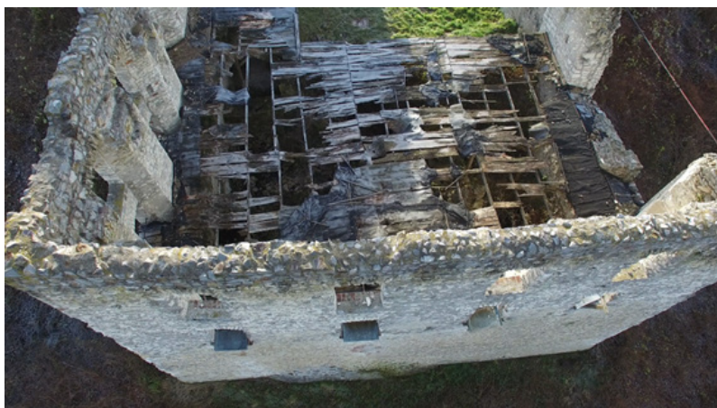
Ryc. 8 Zdjęcie korony muru wykonane przy pomocy drona
