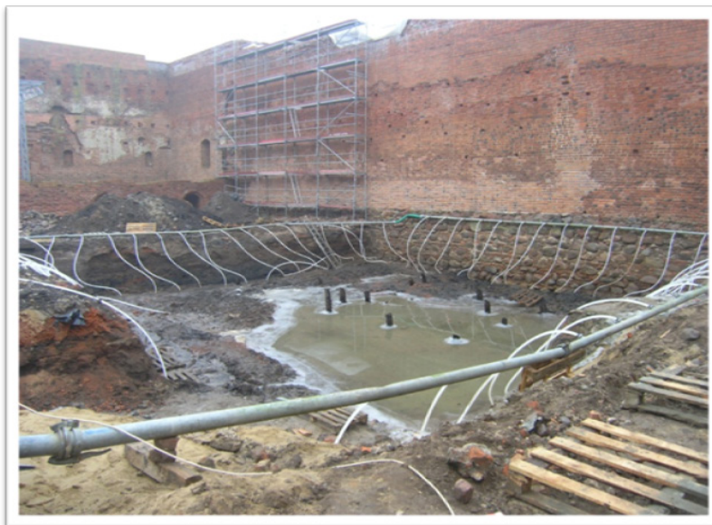
Ryc. 7 Osuszanie terenu dziedzińca w czasie budowy sanitariatów – zbiory MSM
