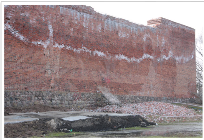
Ryc.5 Widok ściany wschodniej zamku – dokumentacja MSM z przebiegu procesu Rewitalizacji – etap I
