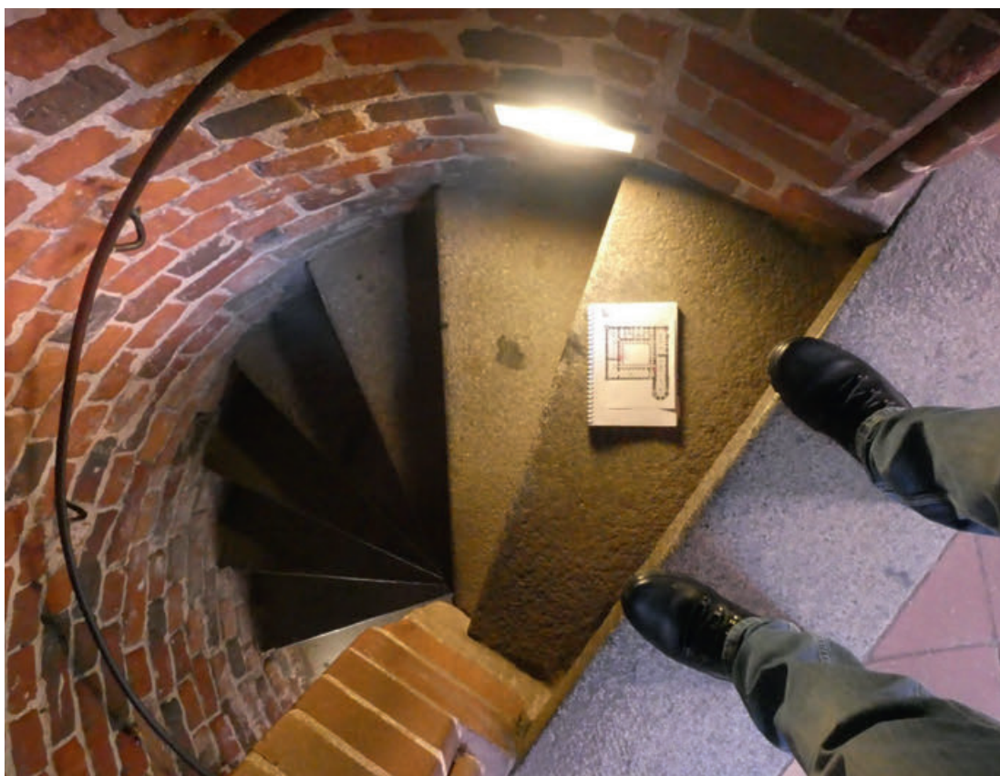
Ryc. 3 Zamek Wysoki w Malborku. Typowa klatka schodowa; leżący na stopniu notes formatu A5 pokazuje skalę szerokości biegu, fot. G. Bukal
