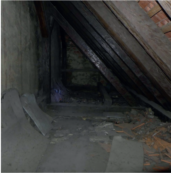
Fot. 15. Poddasze przed przebudową, rok 2015; fot. S. Pankiewicz
