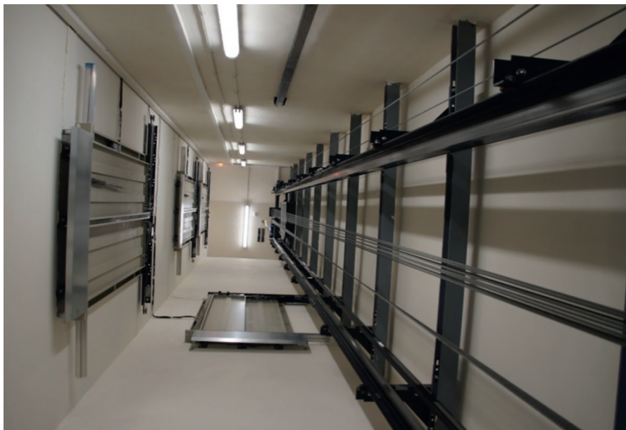
Fot. 14. Wnętrze szybu: mocowanie prowadnic do belek osadzonych w bocznych ścianach, na wprost widoczne są drzwi przystankowe na poziomie II piętra krużganków, rok 2020; fot. R. Jeżowski
