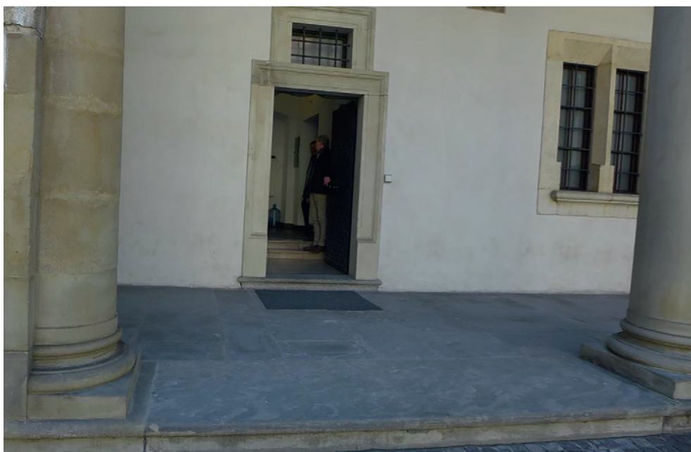
Fot. 4. Bariery dostępu dla osób z niepełnosprawnością z dziedzińca: jeden stopień na całej długości krużganków, jeden stopień w portalu, dwa stopnie we wnętrzu na parterze, rok 2015; fot. S. Pankiewicz
