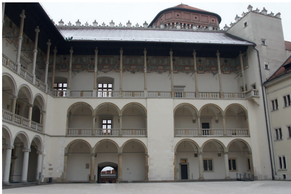
Fot. 1. Południowe skrzydło Dziedzińca Arkadowego, dźwig usytuowany jest za środkowym filarem, rok 2020; fot. R. Jeżowski
