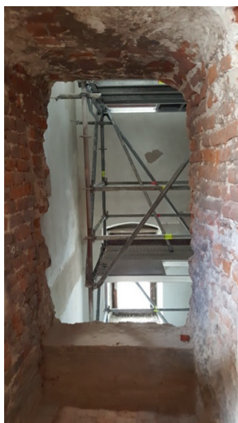
8. Przebicie z krużganków do szybu dźwigowego, rok 2018; fot. S. Pankiewicz
