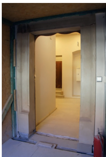
Fot. 7. Posadzka na parterze obniżona do poziomu krużganku, zlikwidowany próg, rok 2018; fot. R. Jeżowski
