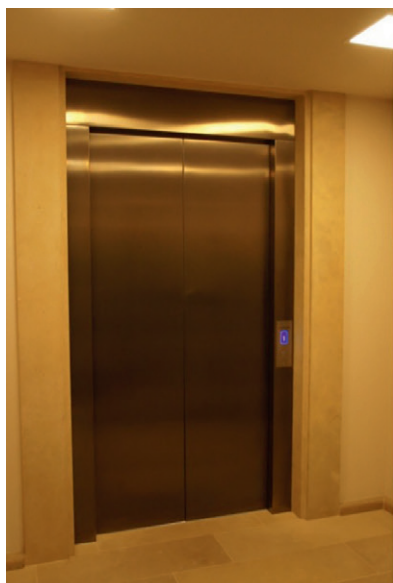
Fot. 13. Drzwi przystankowe dźwigu z obróbką kamienną, rok 2018; fot. R. Jeżowski
