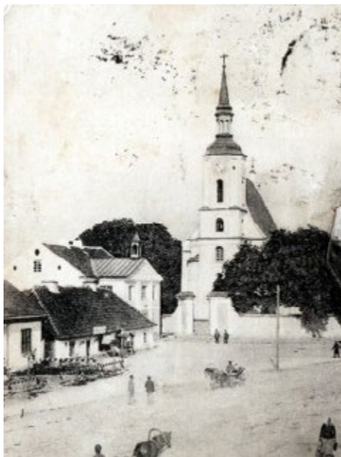
Ryc. 1. Kościół pw. Wniebowzięcia Marii Panny (1617–1626)
