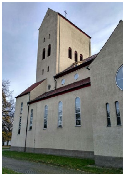
Ryc. 15. Fragment elewacji południowej
