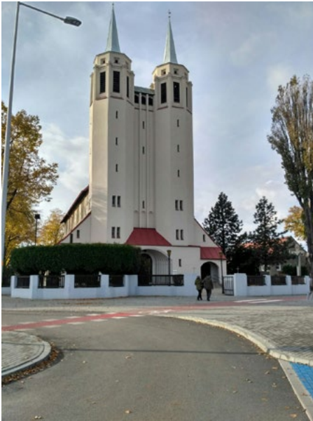
Ryc. 10. Elewacja wschodnia z dwoma wieżami.
