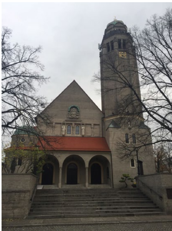
Ryc. 2. Widok kościoła od strony zachodniej.
