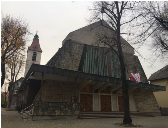
Ryc. 7. Przebudowana elewacja północna.
