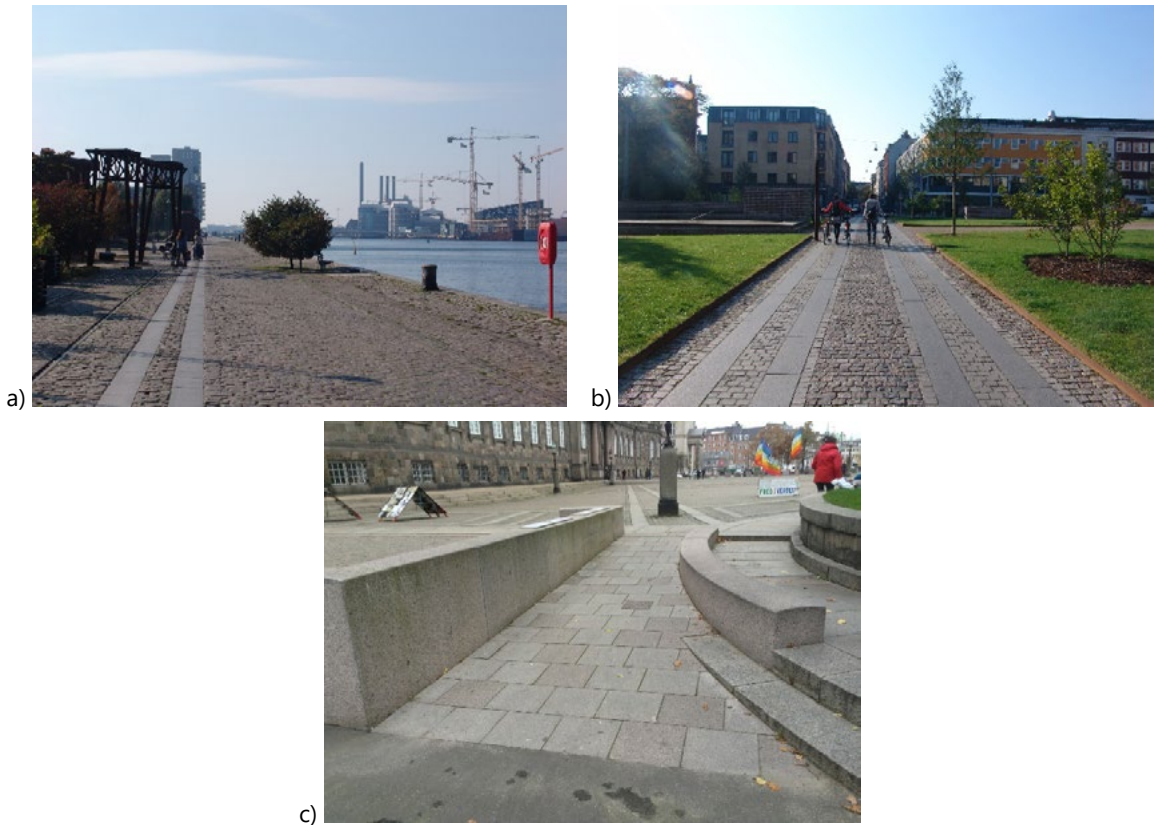
Ryc. 7. Ryc. 7. Zróżnicowanie materiału: A,B – Kopenhaga, zróżnicowanie faktury nawierzchni oraz wielkości elementów tworzy pasy naprowadzające; C - Kopenhaga – różnica w materiałach wskazuje na poszczególne elementy terenu, pasy płyt kamiennych wskazują na najważniejsze kierunki w przestrzeni; fot. E. Przesmycka;
