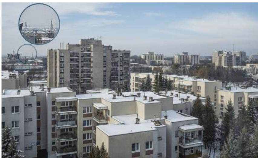
Ryc. 4. Widok na osiedle od strony wschodniej. Na górze z lewej widoczne budynki historycznej części Zamościa. Autor fotografii: Filip Springer Eastern view of the Jan Zamoyski's District. On the upper-left, buildings of the historical part of Zamość can be seen. Author of the photography: Filip Springer
