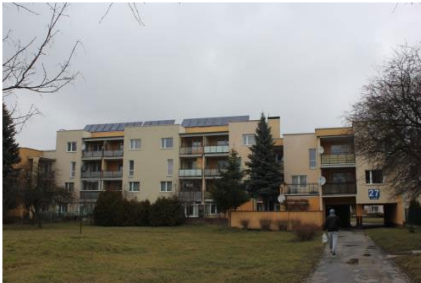
Ryc. 19. Zainstalowane na dachu budynku panele solarne. Autor fotografii: Michał Dmitruk
