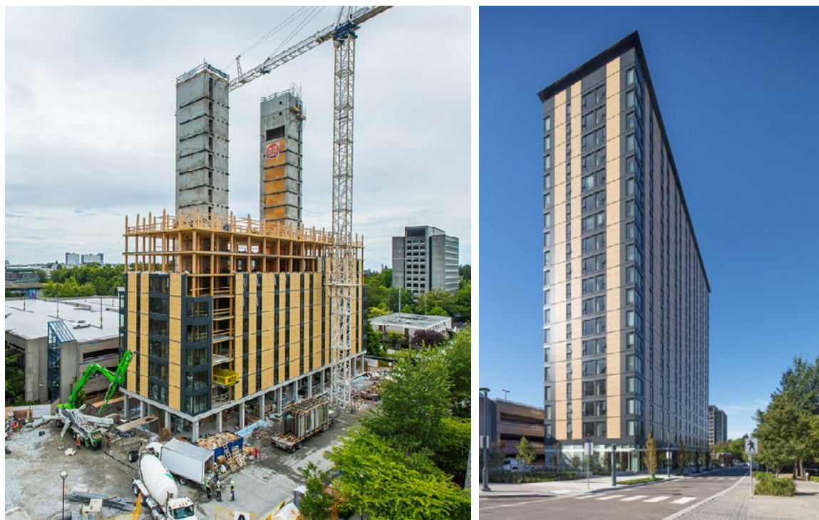
Ryc. 4. Widok na budynek Brock Commons Tallwood House w Vancouver, w czasie realizacji i po zrealizowaniu Źródło: https://www.flickr.com/ licencja otwarta, stan na dzień 20.03.2020.
