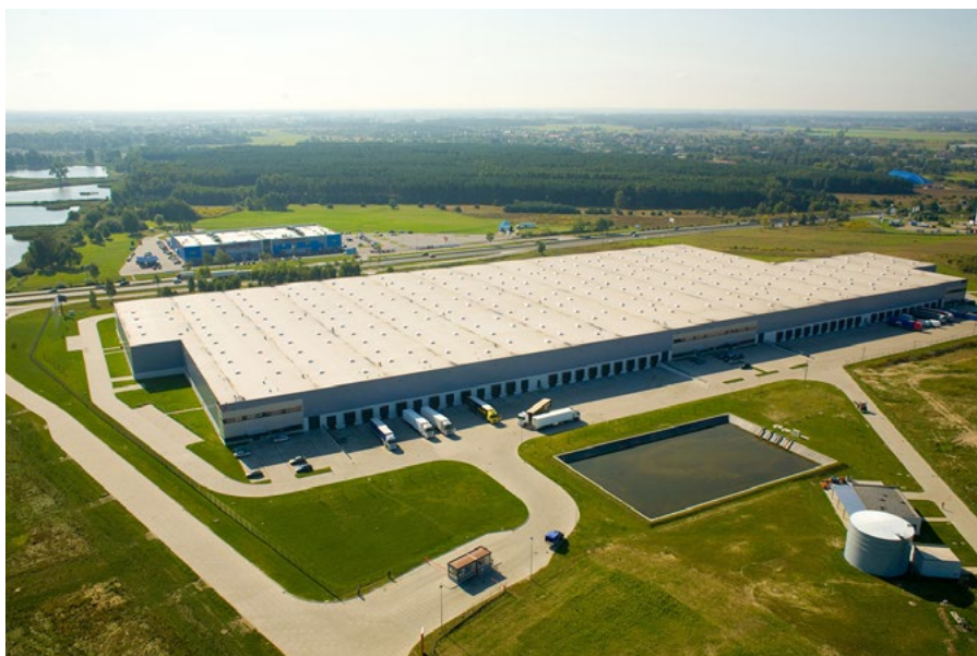
Ryc. 2. Hala magazynowa w układzie przelotowym prostym, Segro park Nadarzyn. Źródło: http://grupa-ls.eu/en/category/en-news/
