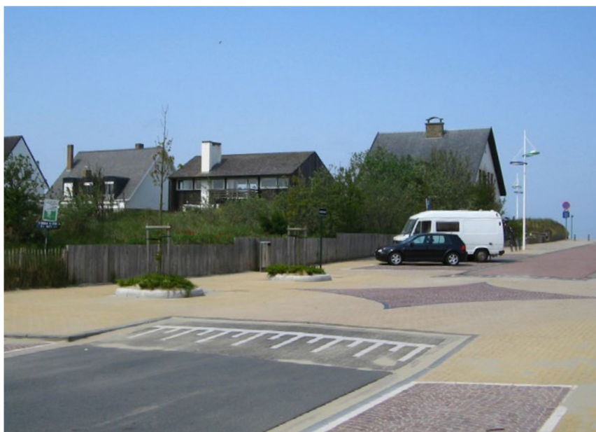
Ryc. 7. i 8. Zeebrugge, Belgia. Wyniesione skrzyżowanie rozwiązane w taki sposób, iż jego powierzchnia stanowi integralną całość z powierzchnią przyległych chodników. Źródło: fot. H. Trammer, 4 maja 2007 r.
