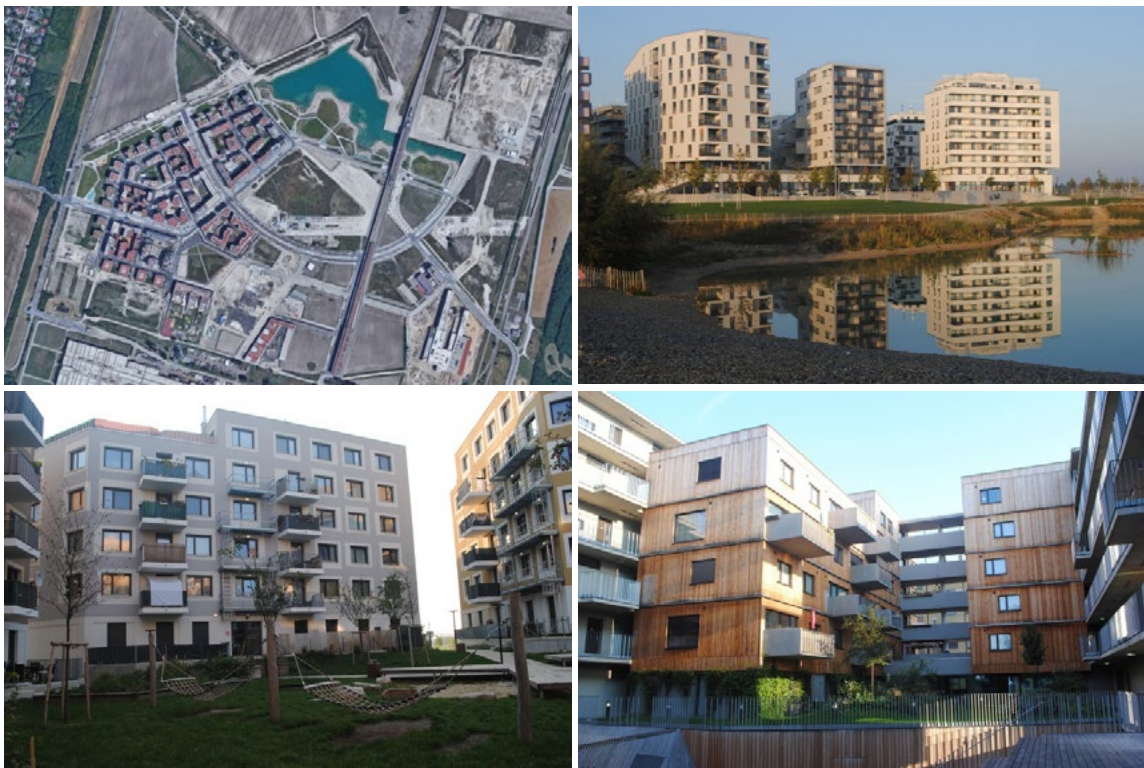
Ryc. 20. Austria, Wiedeń, dzielnica Seestadt. A) Fotografia lotnicza. B) Widok ogólny realizacji zlokalizowanych w sąsiedztwie zbiornika wodnego. C) WAS – Wohnbau (2015, arch. AllesWirdGut). D) Holzwohnbau (2011–15, arch. Alfred Berger, Tiina Parkkinen – Architekten Berger + Parkkinen Ziviltechniker GmbH).
