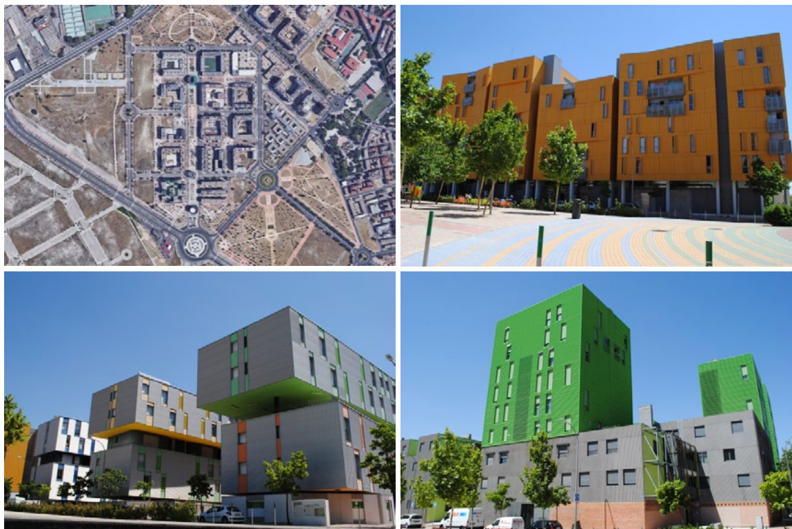
Ryc. 13. Hiszpania, Madryt, obszar wokół Bulevar de la Naturaleza na terenie Vallecás w Madrycie. A) Fotografia lotnicza. B) Edificio Vallecás 16, (2007, arch. Javier Camacho). C) Edificio Vallecás 5 (2006–09, arch. Luis Burriel Bielza, Pablo Fernandez Lewicki, Jose Antonio Tallon Iglesias – SOMOS Arquitectos). D) Edificio Vallecás 4 (2008, arch. Hugo Araujo Lazare – Araujo+Brieva Arquitectos).
