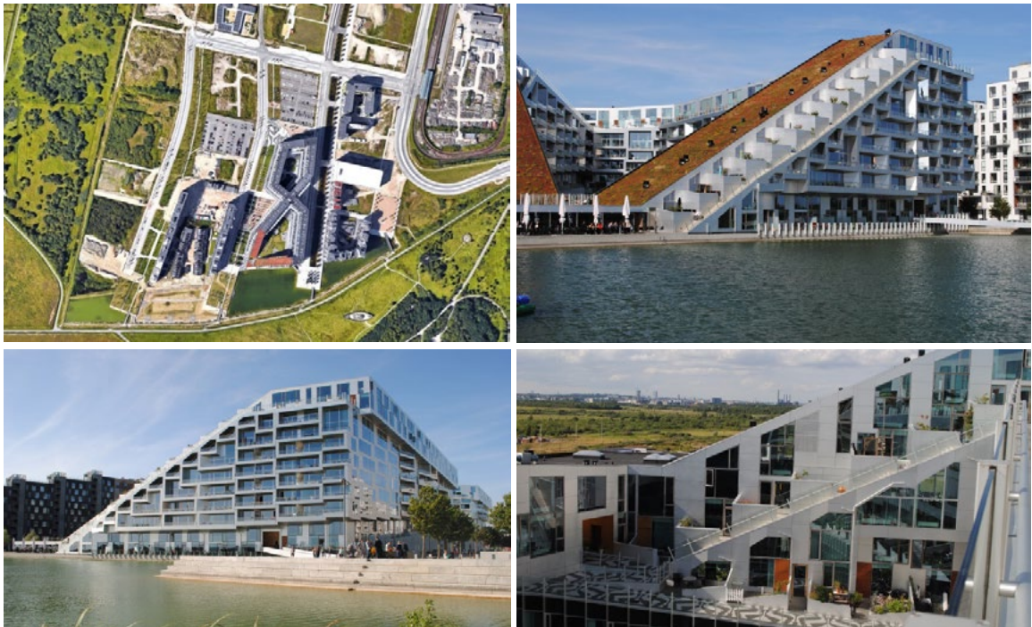
Ryc. 4. Dania, Kopenhaga, dzielnica Ørestad, zespół mieszkaniowy 8 Tallet (2006, arch. Bjarke Ingels). A) Fotografia lotnicza. B,C,D) Widoki budynku.
