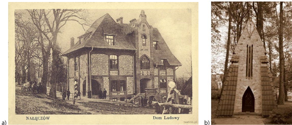
Ryc. 8. Witrażowy wątek wykonany z „siwaka” w formie płaskiej dzikówki w elewacji Domu Ludowego w Nałęczowie (a), mauzoleum Adama Żeromskiego w Nałęczowie (b).
