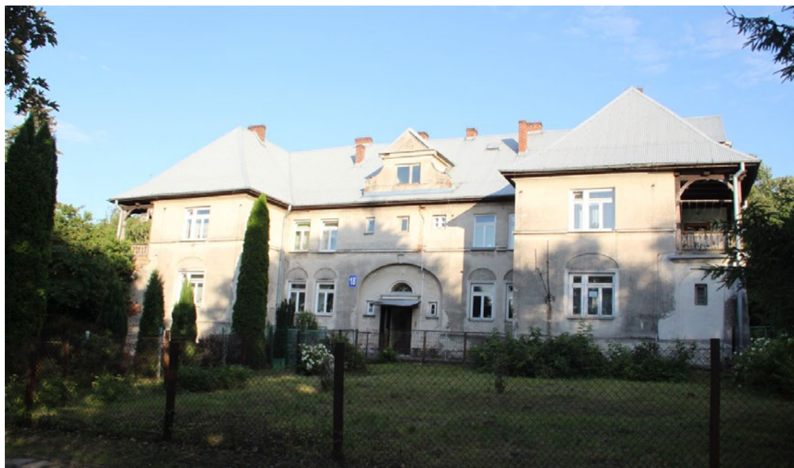
Ryc. 10. Dom Urzędników – stan obecny, fot K. Boguszevska, lipiec 2017
