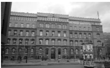
Ryc. 2. Politechnika Krakowska – budynek główny.
