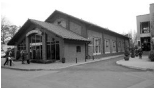
Ryc. 1. Politechnika Krakowska – Kotłownia.
