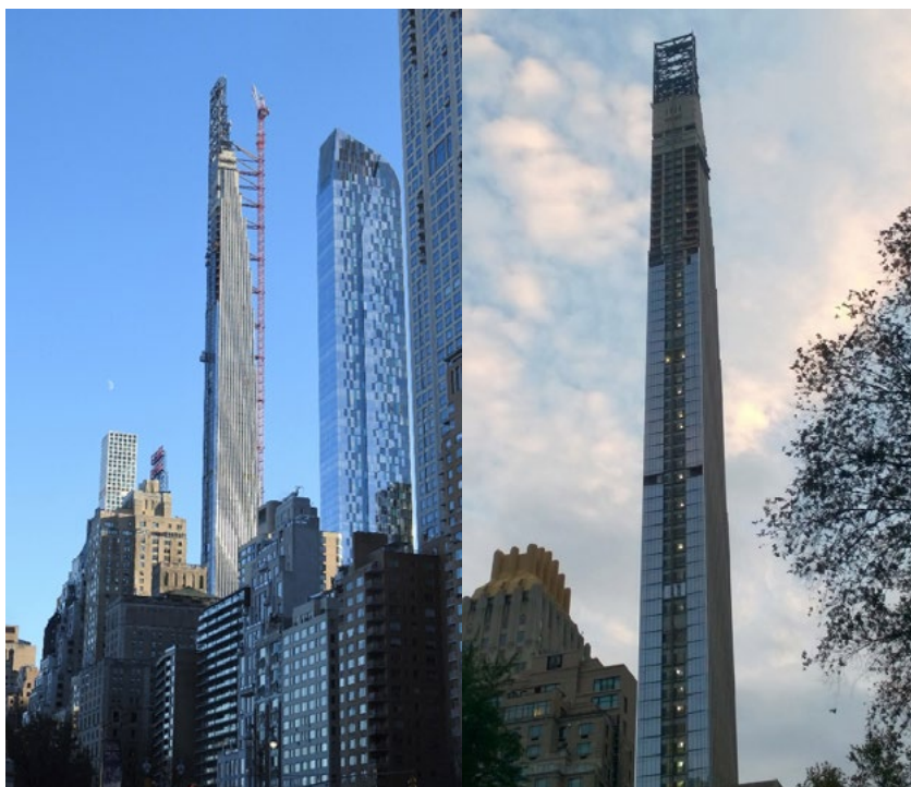
Ryc. 3. Budynek 111 West 57 th Street w trakcie konstrukcji. Źródło: wikipedia.org, na licencji CC BY-SA 4.0F
