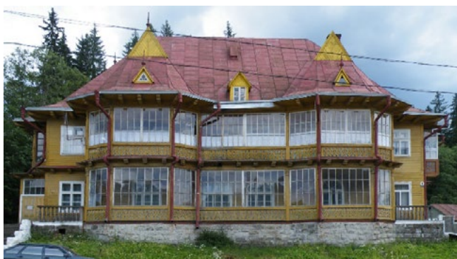
Ryc. 14. Worochta. Dawny pensjonat „Liliana”. Elewacja zachodnia (Fotografia autora, 2009 r.)
