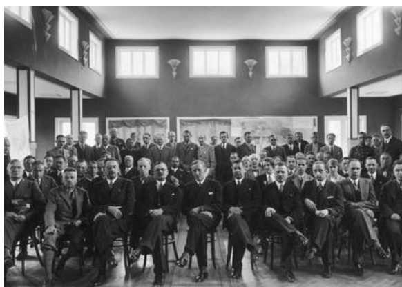
Ryc. 4. Jaremcze. Dawna restauracja Skrzyńskiego. Widoczne wewnątrz sali restauracyjnej z uczestnikami Zjazdu Turystyczno-Uzdrowskiego w Jaremczu w 1934 r. Na wysokości drugiej kondygnacji widoczne są okna świetlika (NAC, sygnatura: 3/1/0/14/3589/1)
