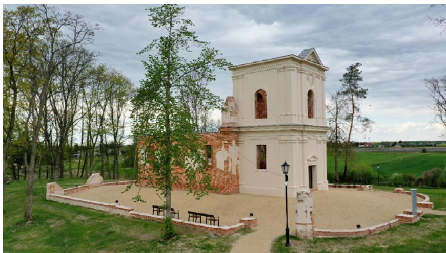
Ryc. 9. Fotografia przedstawiająca Stan istniejący obiektu (rok 2019) – źródło Urząd Miasta Piaski
