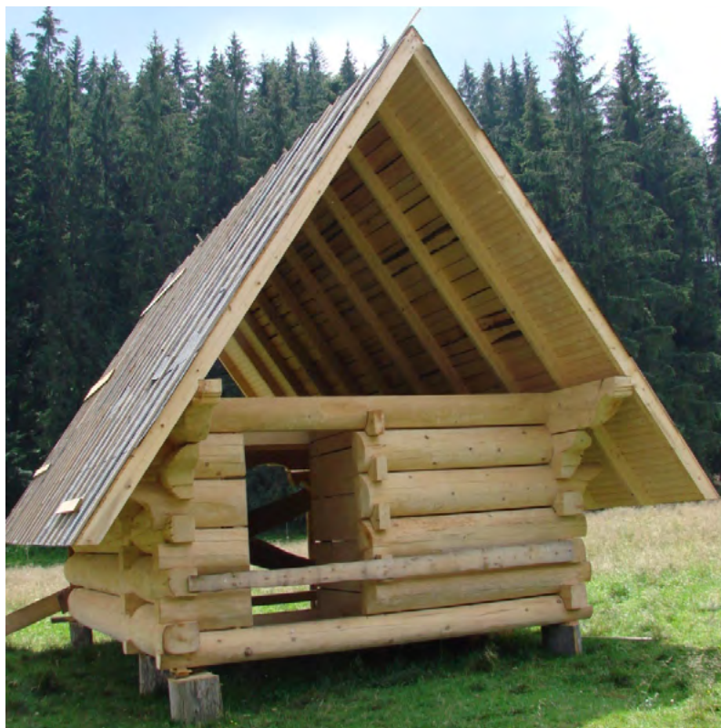
Ryc. 7. Tatry Polskie. Dolina Chochołowska. Współczesny szałas pasterski, budowany wg tradycyjnej metody, przy drodze do Doliny Chochołowskiej, fot. Autor, 2014 rok
