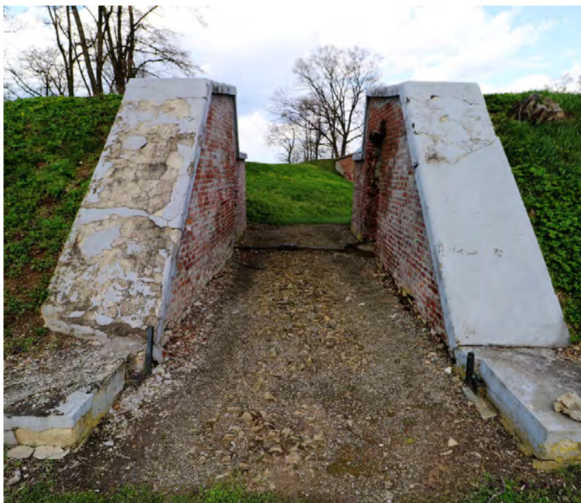
Ryc. 3. Fotografia przedstawiająca zabezpieczenie przejścia przez wał ziemny w Fortcie XV Borek – zdjęcie Piotr Gleń
