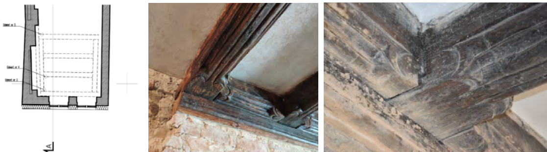
Ryc. 10. Belki drewniane – pozostałości stropu drewnianego zlokalizowane pod stropem 1 piętra w budynku Wroniecka 23
