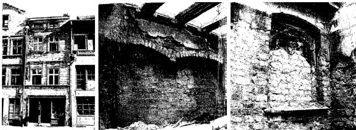
Ryc. 9. Zdjęcia pozyskane z zasobów Miejskiego Konserwatora Zabytków
