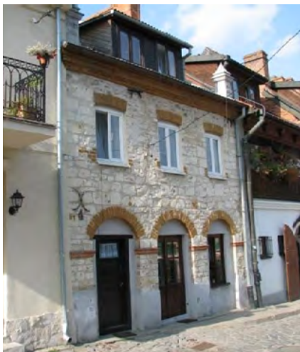
Ryc. 11. Kamienica w zabudowie zwartej. Kazimierz Dolny nad Wisłą
