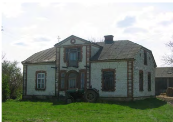
Ryc. 19. Budynek jednorodzinny. Gmina Trawniki
